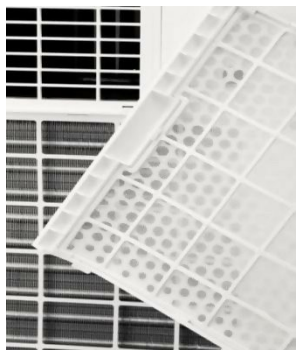
Fig.3 : Eteignez l'appareil et retirez le filtre à air.
